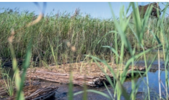
De zelf ontwikkelde Schaikmat, een mat van wilgentenen die gebruikt kan worden als oeverbescherming of als drijvend eiland met waterplanten.
