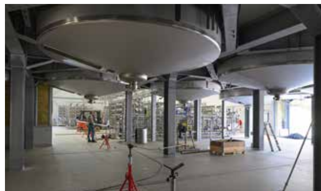
In deze 'hangende tanks' van 160 kuub van Staal 12 uit Dokkum zijn zuivelgrondstoffen of eindproducten opgeslagen.
